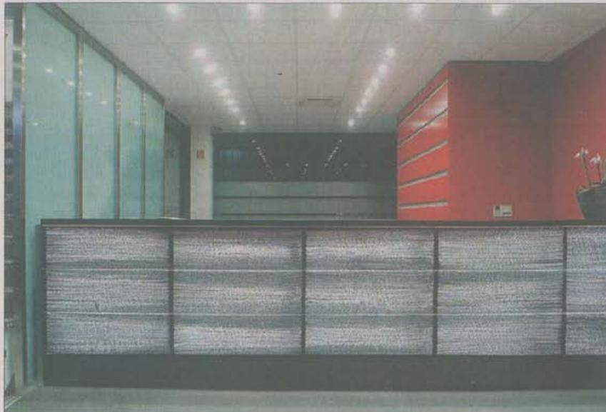
Lichtdurchlässiger Beton der HeidelbergCement am Empfangstresen. Er ist so stabil wie normaler Beton.
